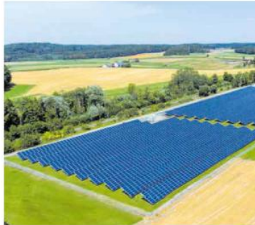
So sieht der neue Solarpark in Ingoldingen aus.
